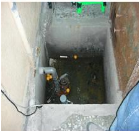
地下室集水槽
