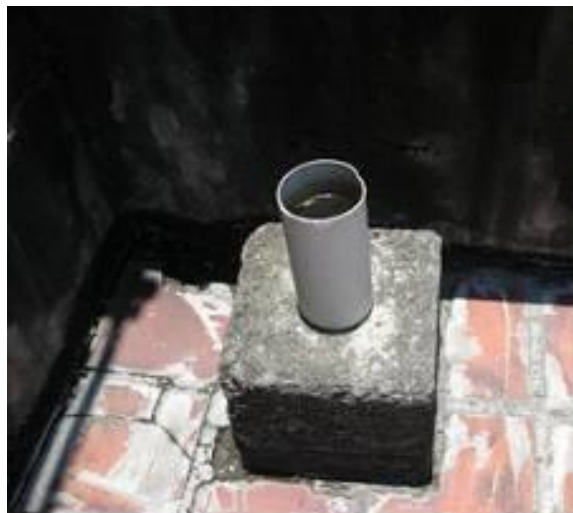
水泥樁上之水管
