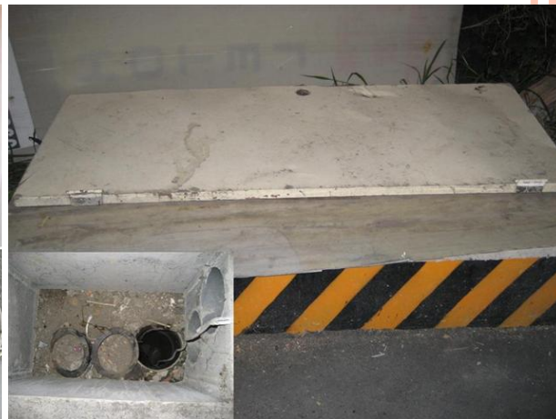
電信電纜管道
