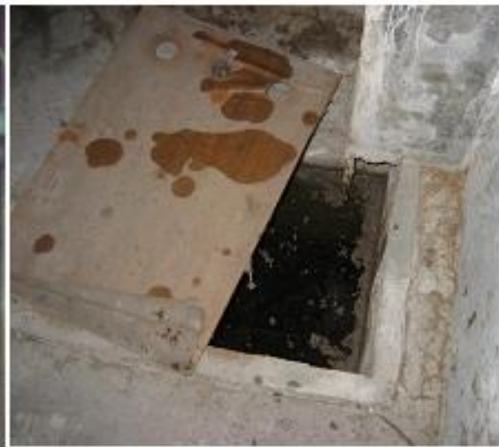
地下室污水池
