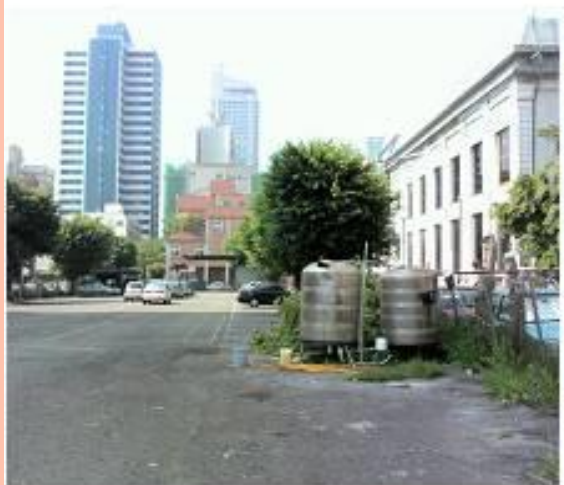
停車廠水塔無蓋
